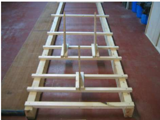
Colocación de soportes de sección
